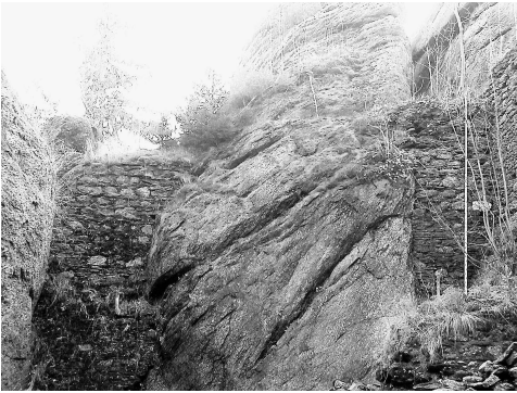
Obr. 3. Východní stěna budovy č. 1 se dvěma vyzdívkami. Pohled od západu.
