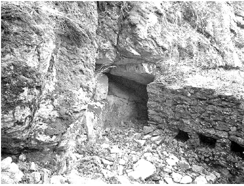
Obr. 6. Jižní část západní stěny s trámovými lůžky prvního patra a střílnou. Pohled od severovýchodu. Abb. 6. Südteil der Westwand mit Balkenlager des ersten Stockwerks mit Schießcharte. Blick von Nordosten.
