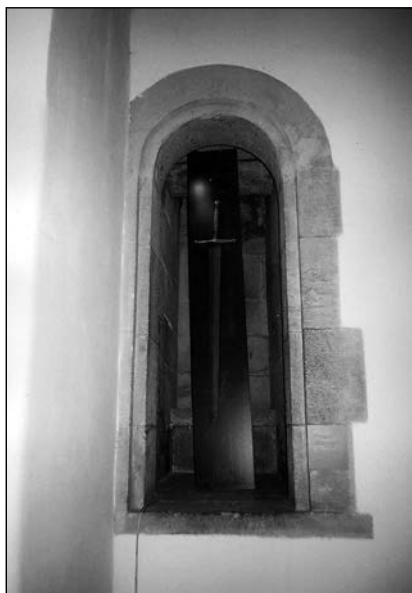
Praha, Malostranská mostecká věž, zazděný portál
