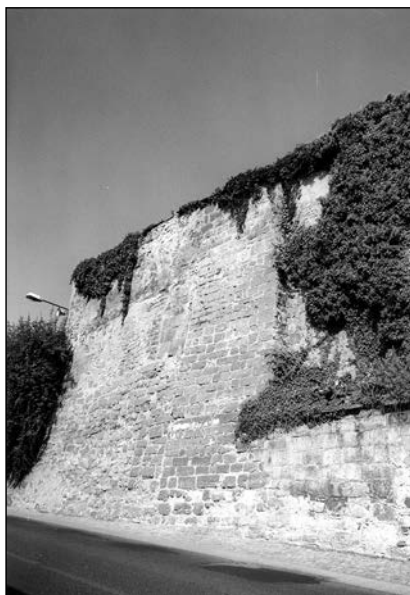
Bělá pod Bezdězem, podpěrná zeď při zámku, zde přiléhala Pražská brána
